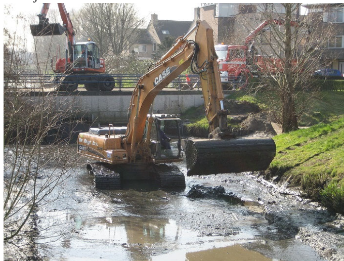
Baggeren in Groot-Sander
